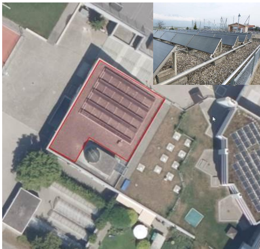
Bestehende Solarthermieanlage, die rückgebaut wird
