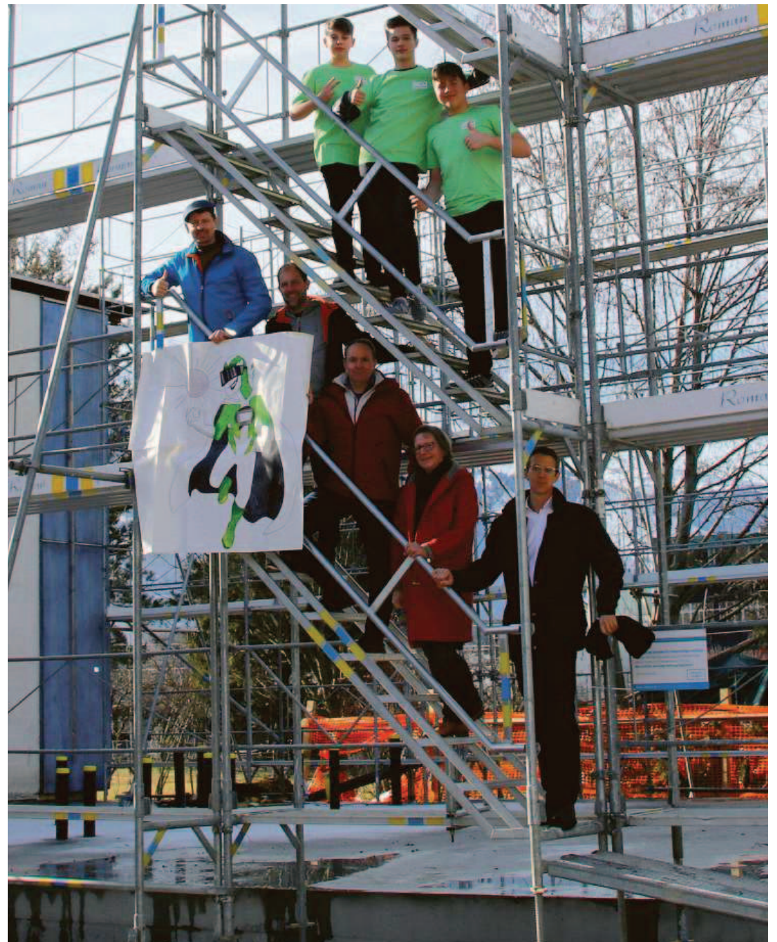
Vertreter der Waldorfschule, des Vereins JugendEnergy, der Büchel-Hoop Photovoltaik AG und der Lenium AG bei der Vertragsunterzeichnung auf der Baustelle des Erweiterungsbaus der Waldorfschule in Schaan. Bild: pd
